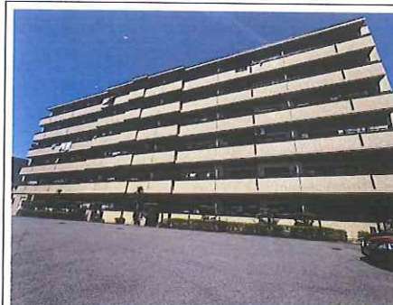
外観全景（2019 年大規模修繕済み）
