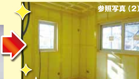
防湿気密シート施工写真
