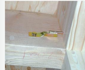
金物は構造部材ごとに適材金物の使用があります。これは中間検査の時に検査員が厳しくチェックします。
