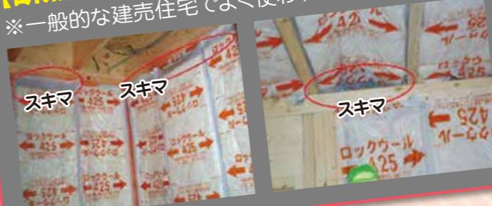
黄色いシート(防湿気密シート)でスキマなく壁をおおい室内を魔法瓶のような状態にします。電気のコンセントやエアコンのダクト等は気密ボックスと気密テープでしっかりとふさぎます。断熱性能は断熱材だけではダメで、気密もしっかりやってはじめて断熱性能が高くなります。プレゼンスでは、隠れて見えなくなる断熱材の施工を第三検査機構「日本住宅保証検査機構」で、厳しい検査を受け、全棟合格してから壁を仕上げています。※検査報告書も提示いたします。(検査状況写真添付)
