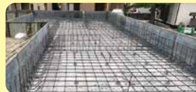
基礎の配筋(鉄筋)工事
